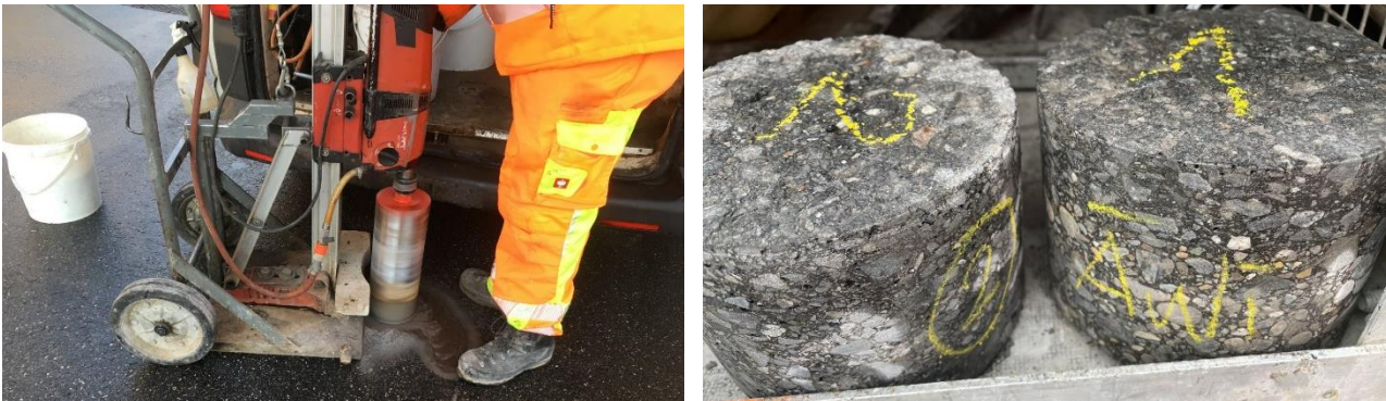
Abbildung 4: Bohrkernentnahme aus Strasse
