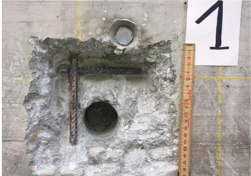
Abbildung 6: Spitzarbeiten zur Öffnung eines Sondagefenster ca. 20 x 20 cm mit 1. und 2. Bewehrungslage
