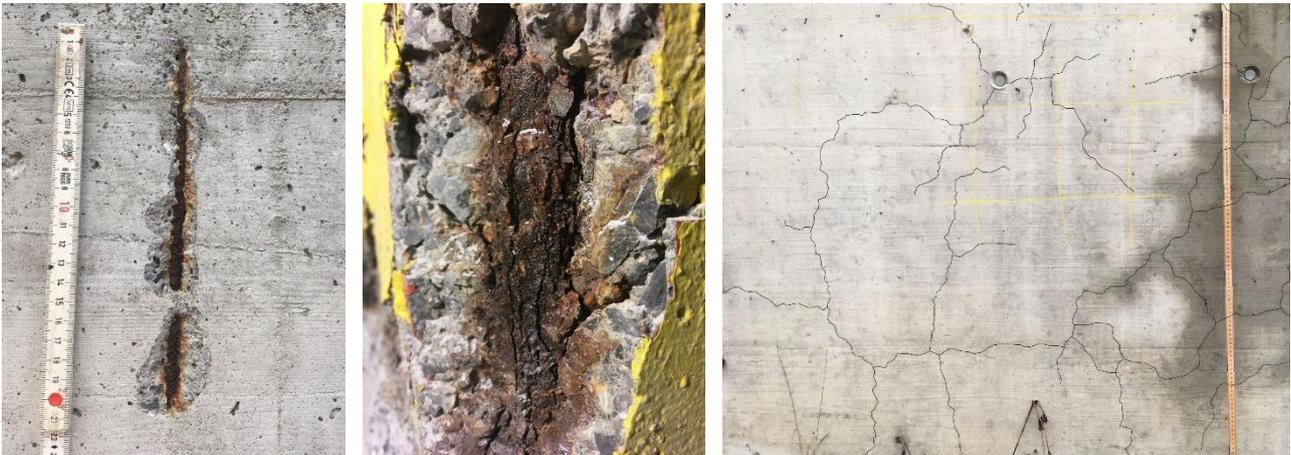
Abbildung 1: Schadstellen am Objekt und Rissaufnahme (nachträglich bearbeitetes Foto)
